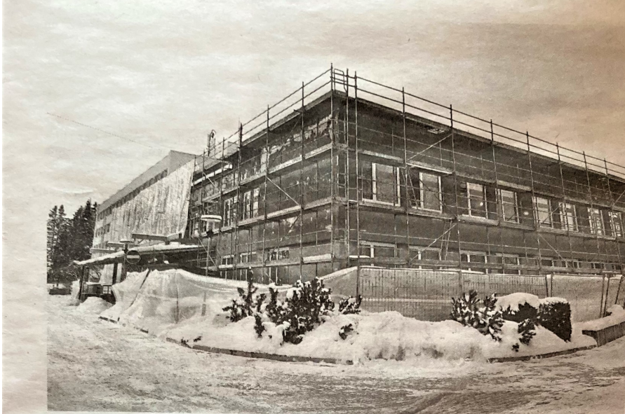
■ATDZIMST. Cēsu klīnikā darbi rit gan ārstniecības korpusa visos stāvos, gan arī diagnostikas korpusā, kur notiek āršieni un jumta siltināšana.
